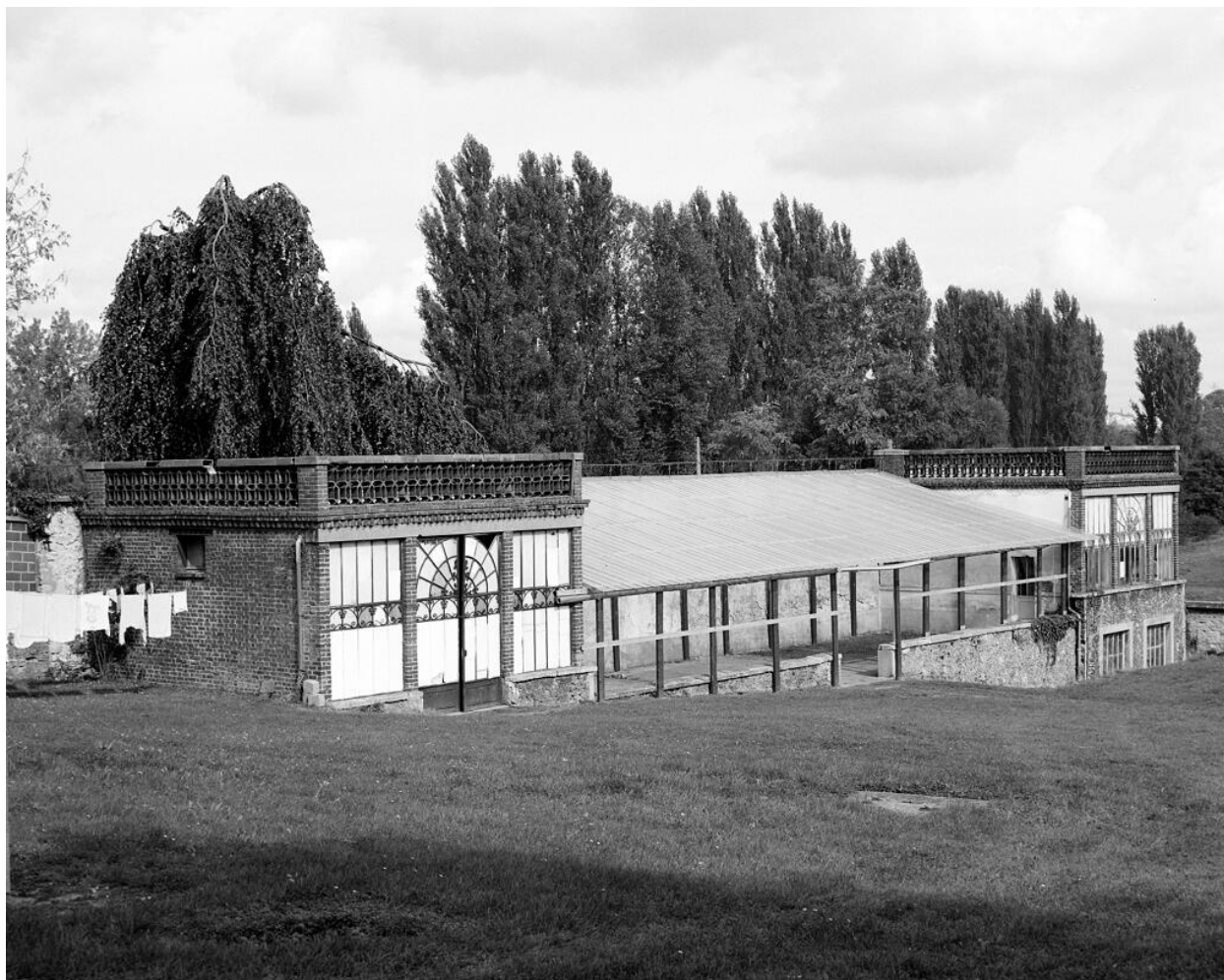
Serres (en cours de restauration).
