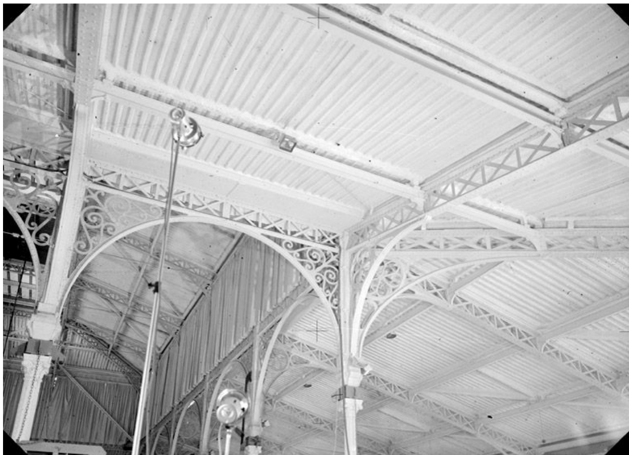
Jonction entre les arcades et les fermes transversales. Couple photogrammétrique.
