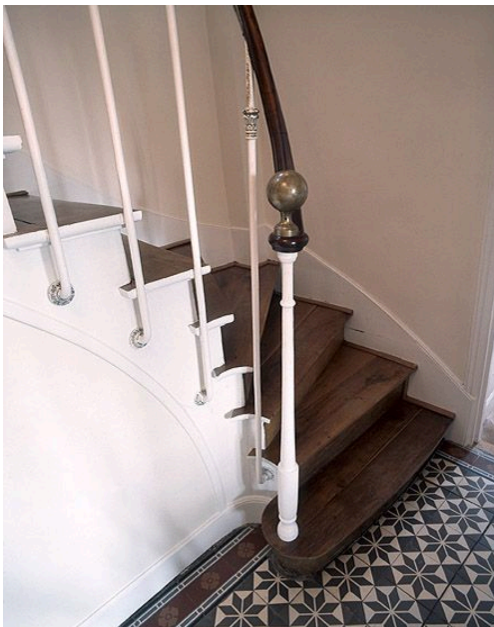
Le départ de l'escalier à marches formant limon et à col de cygne.
