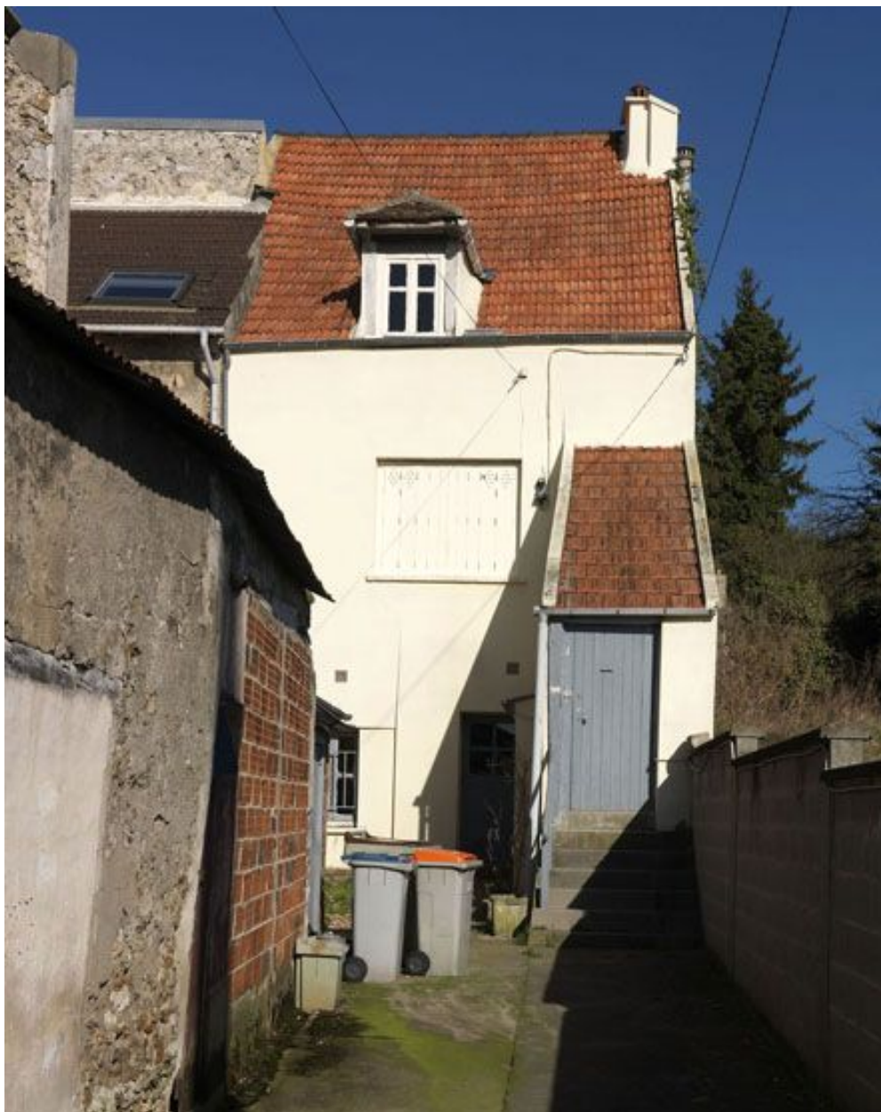
Escalier extérieur et cellier en rez-de-chaussée.
