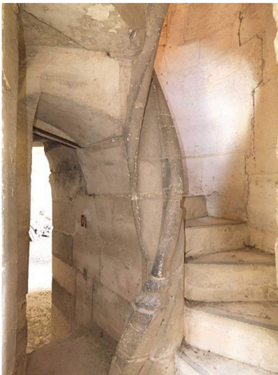
Escalier d'accès à la tour nord.
