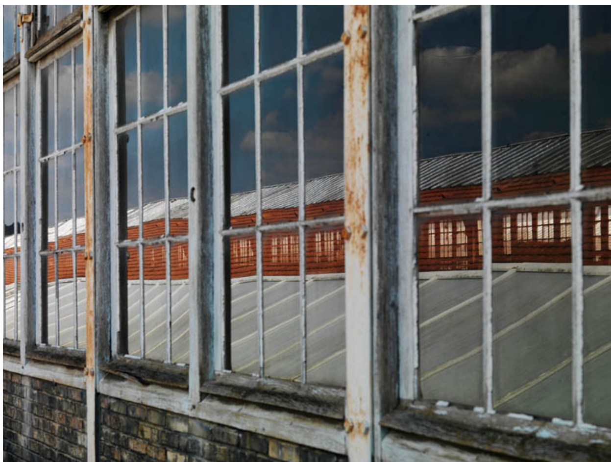
Détail des verrières des côtés de la nef centrale.
