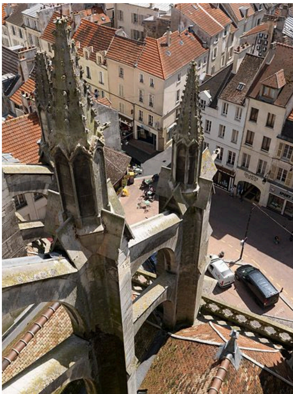
Détail d'un arc-boutant, du côté sud de la cathédrale (vers la rue Saint-Etienne). Vue prise depuis la balustrade supérieure du chœur.
