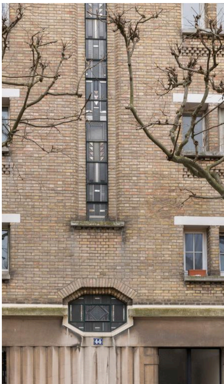
Détail de la verrière de la cage d'escalier
