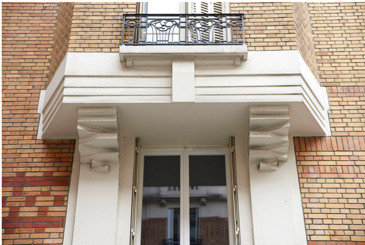
Vue de la ferronnerie d'un balcon.
