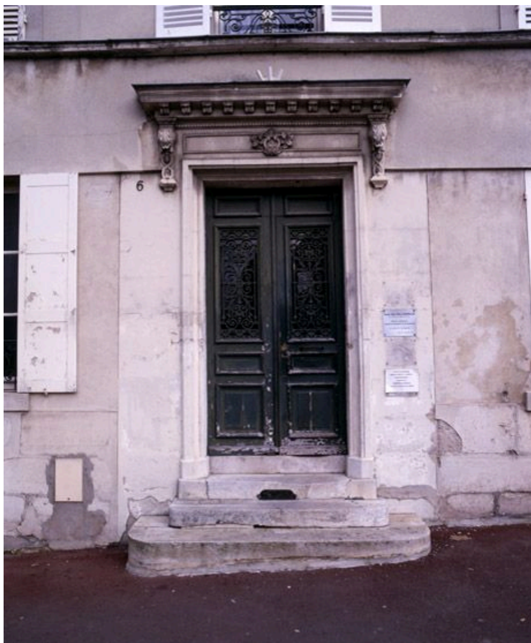
Immeuble d'angle, 6 place de l'Hôtel de ville, portant la date "1860" sur le linteau de la porte.
