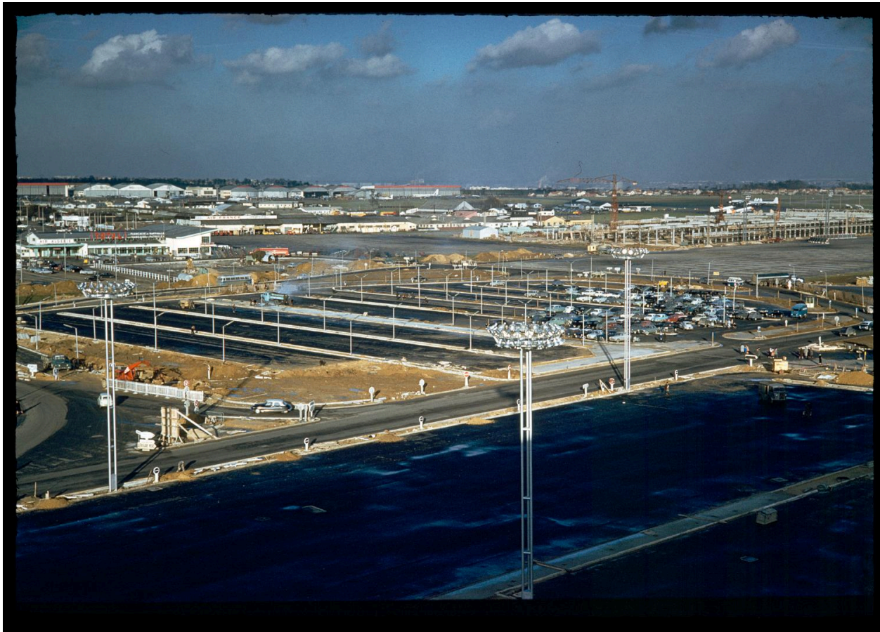
1960, la construction de la gare de fret vue depuis le sud ouest.
