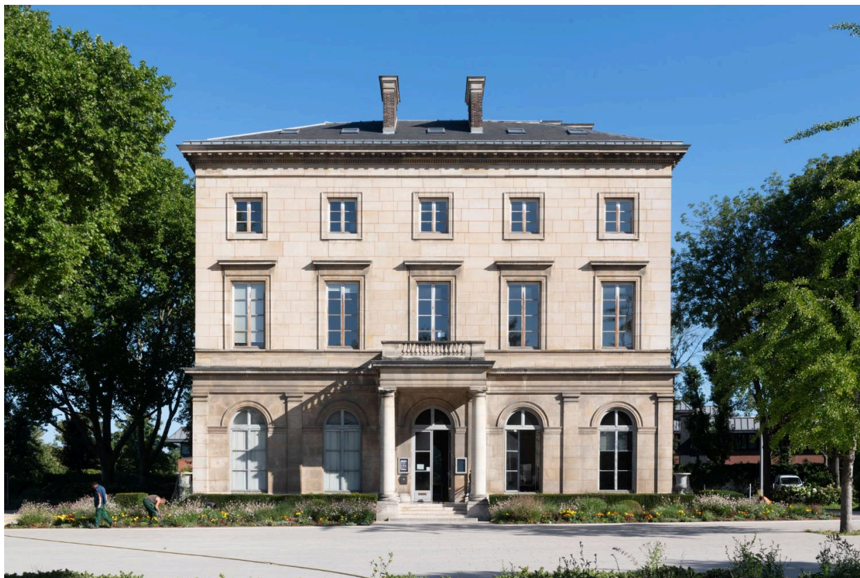
Façade principale, sud-est
