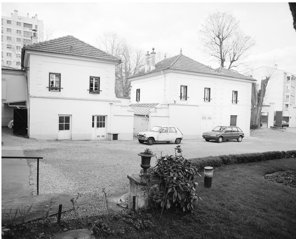
Vue d'ensemble des logements de gardiens situés à l'entrée de la propriété.
