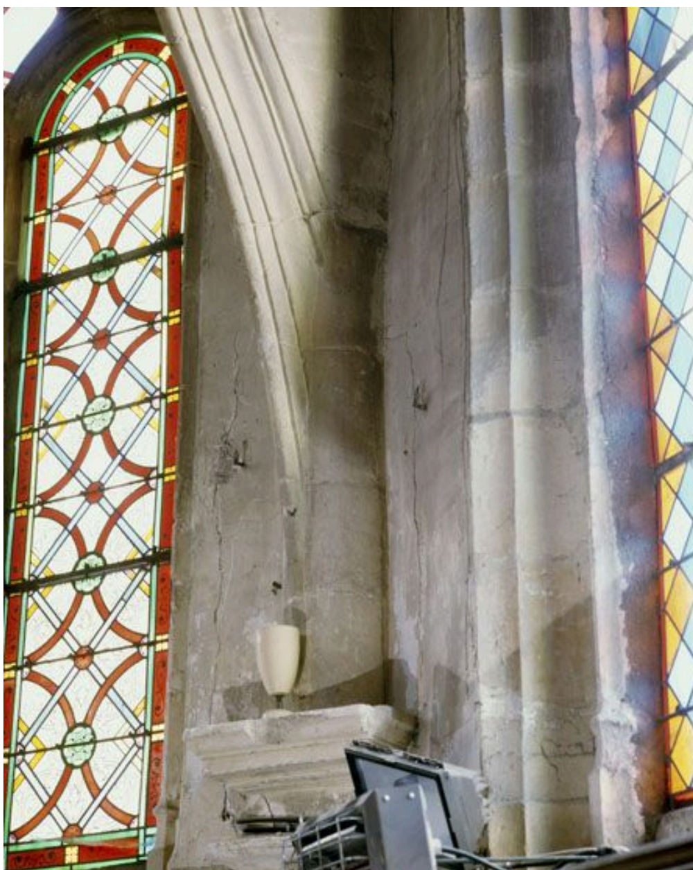
Détail d'une retombée de voûte en pénétration directe.
