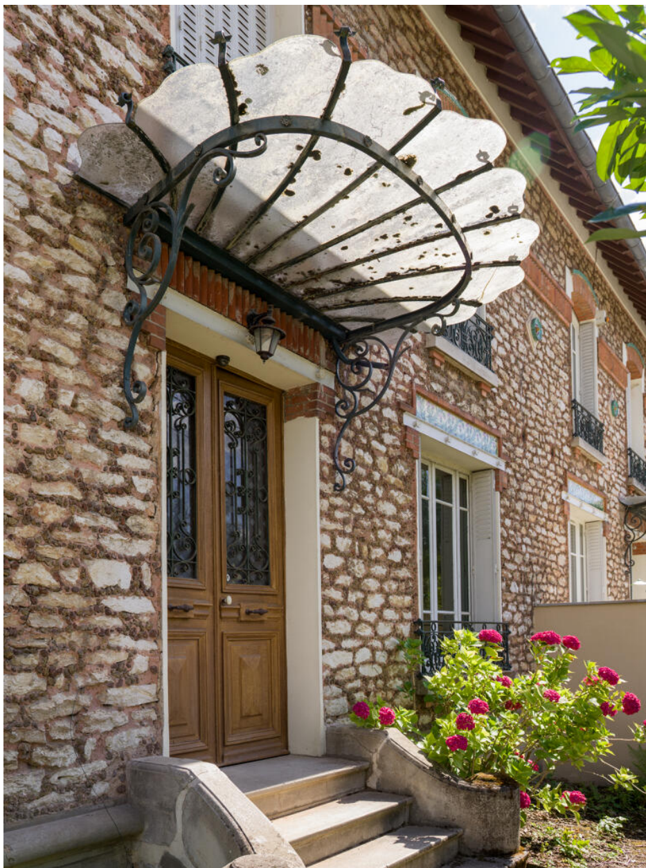
Vue de l'entrée du 25 rue Saint-Pierre depuis le nord-est.
