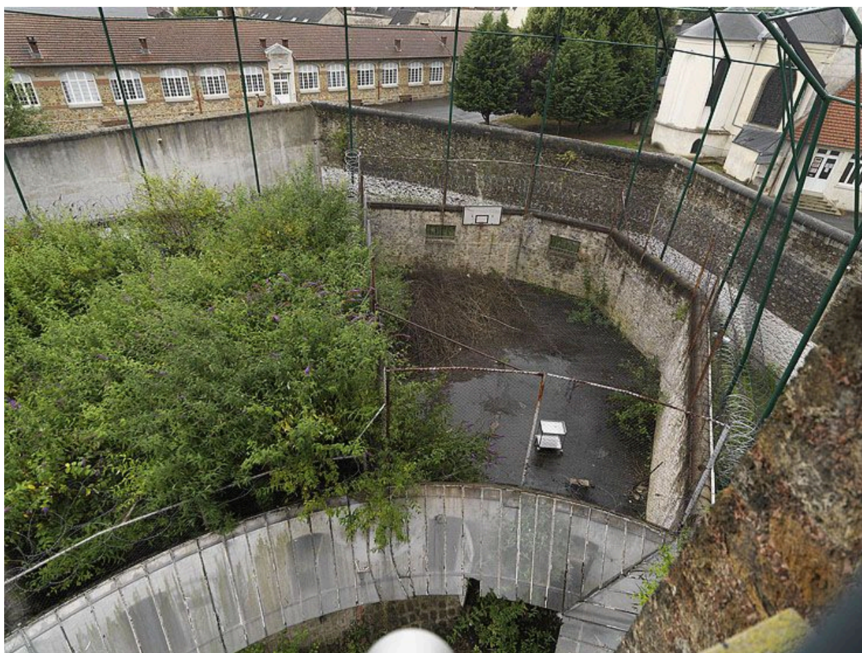
Les cours de promenade, vues depuis le haut (côté sud).
