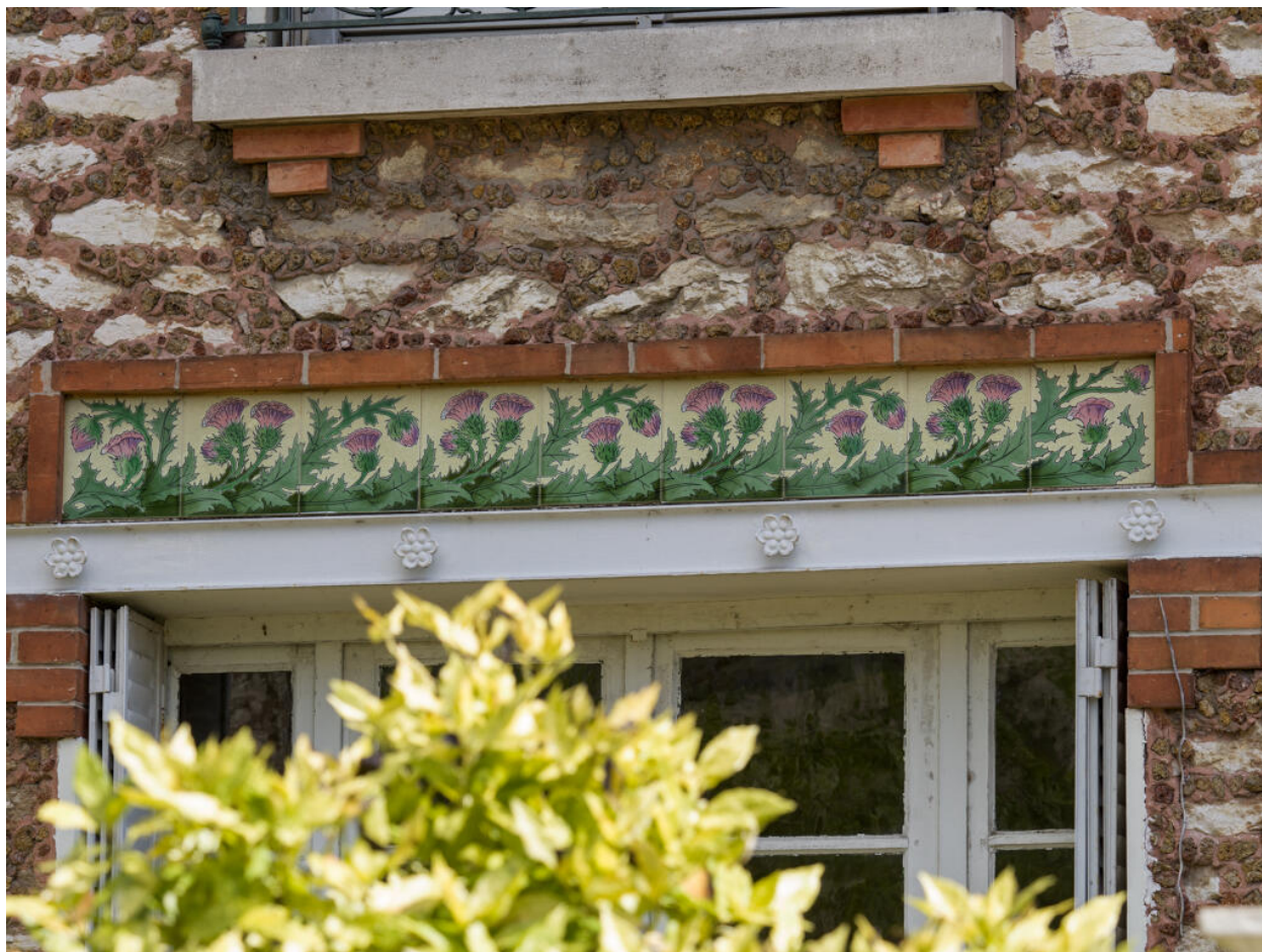
Vue du linteau de la baie du rez-de-chaussée du 25 rue Saint-Pierre.
