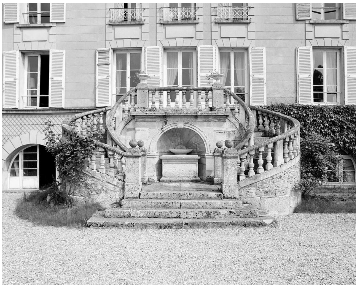
Escalier de la façade ouest.
