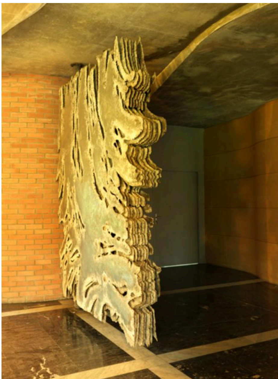
Détail d'une des portes montrant le principe de superposition des feuilles de métal.
