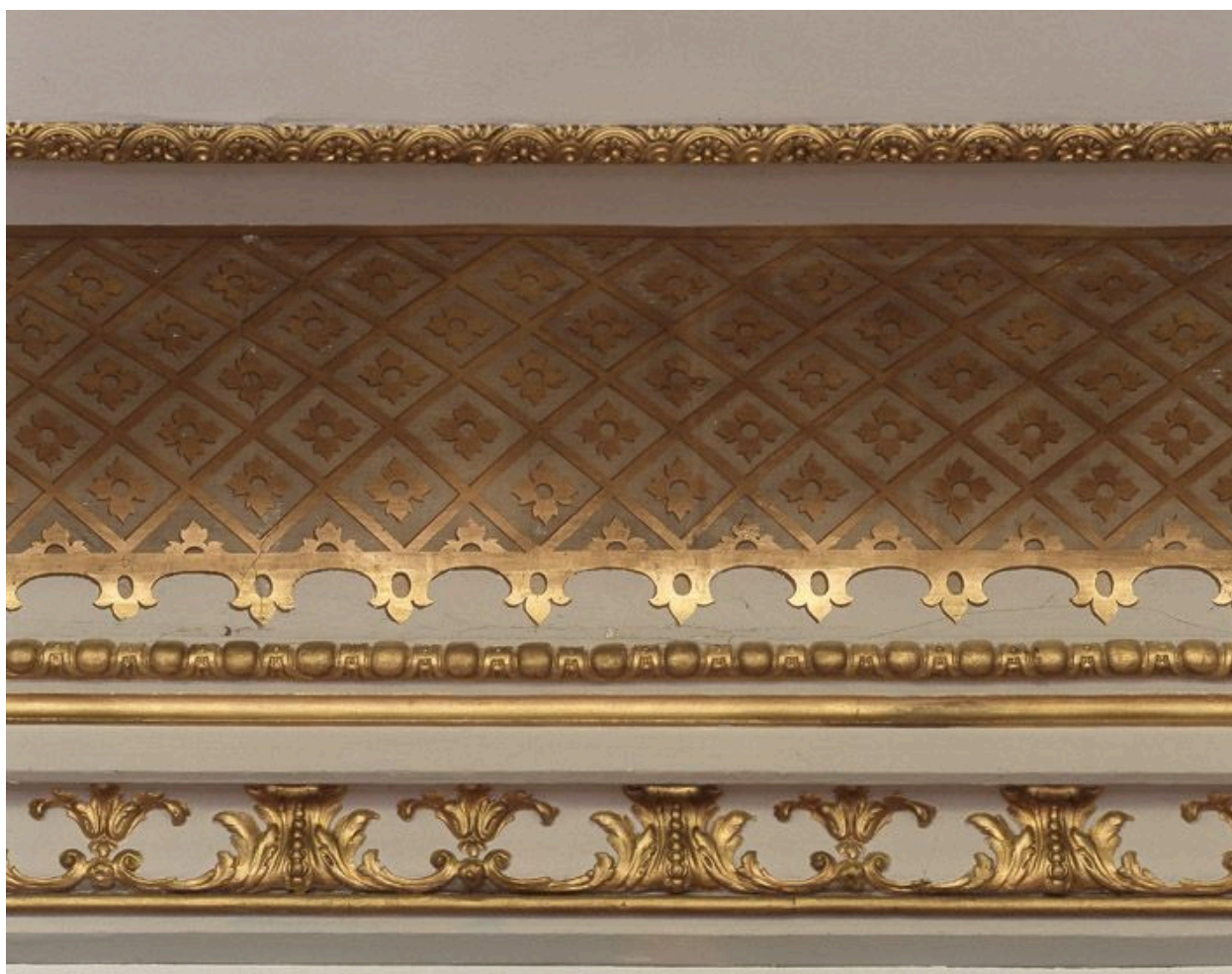
Le grand salon : détail de la corniche.
