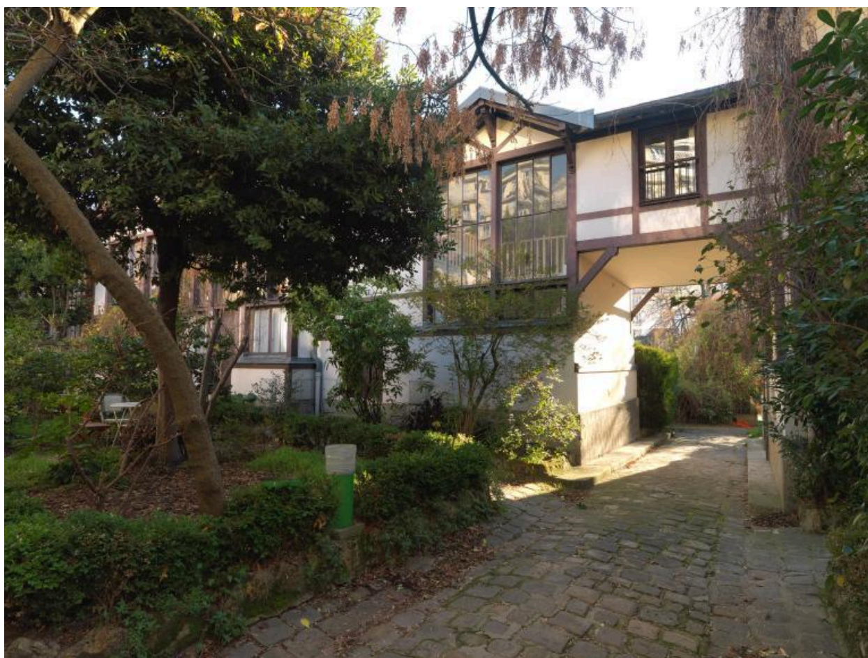
Vue de la première cour intérieure
