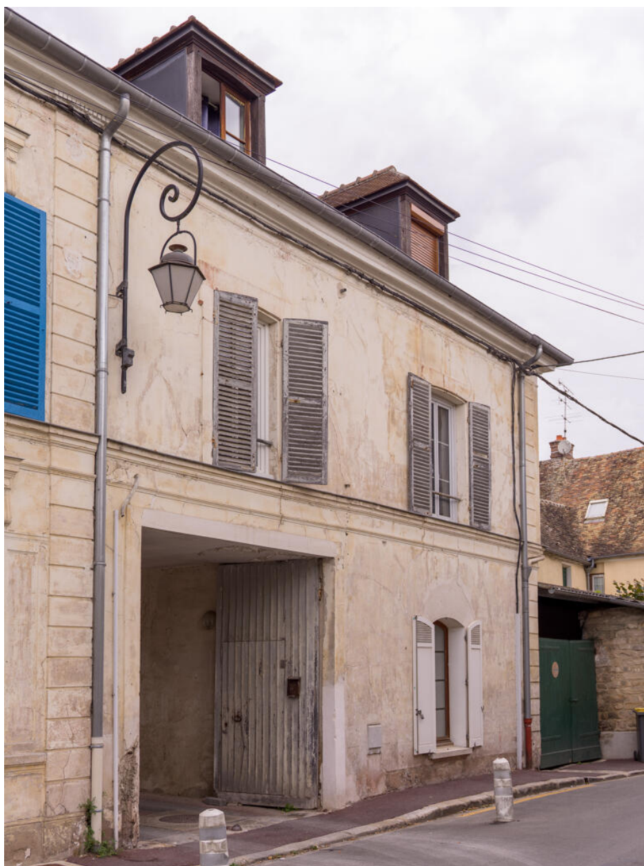
Vue générale de la partie nord de la façade sur la rue Farnault, depuis le sud-est.
