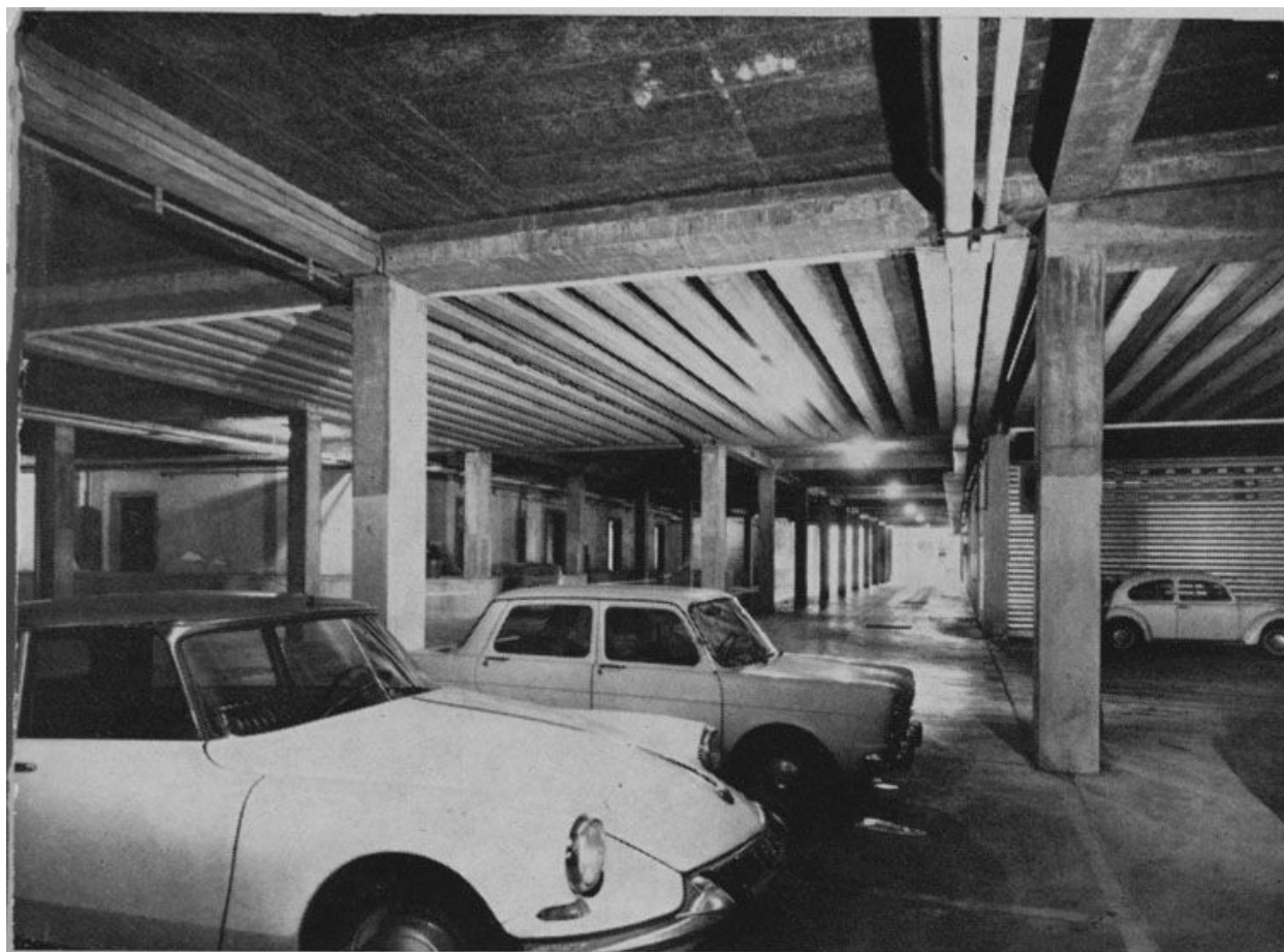
Sous-sol du centre commercial aménagé en parking. Photographie. (AD Essonne, GBR 193)
