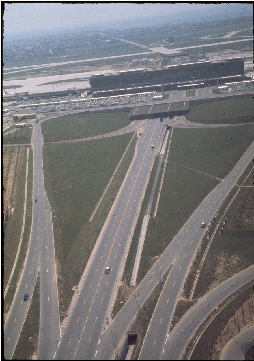
1961, les Installations Terminales vues depuis le nord.
