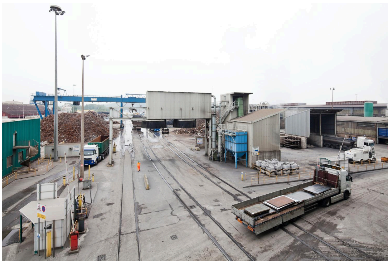
Parc à ferrailles. (réf. Département Seine-et-Marne : IVD77_2013_77_00234_NUCA)
