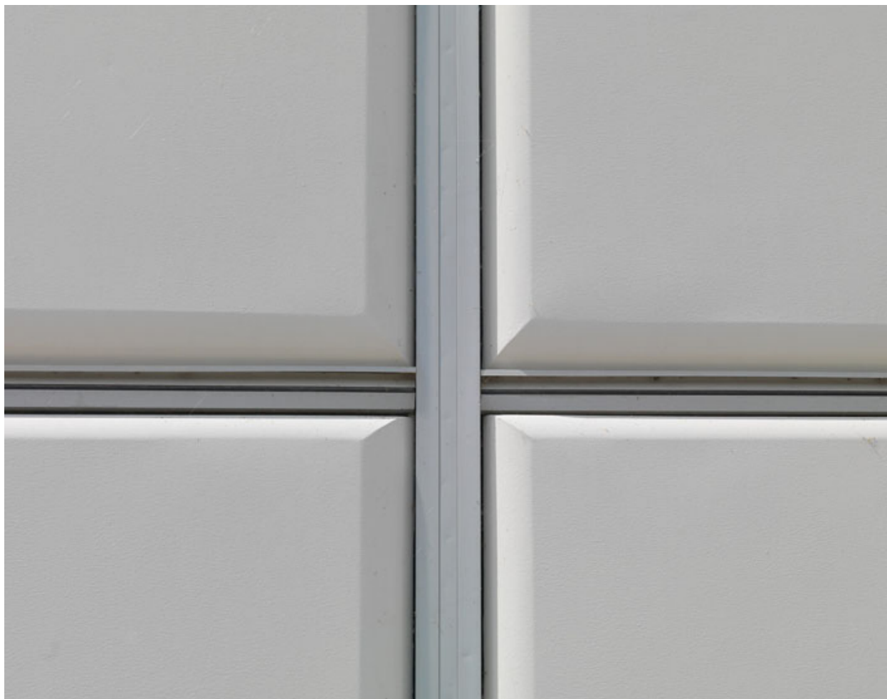
Laboratoire d'essais classique blanc de type Prouvé. Détail. Assemblage des panneaux. Traitement du joint.
