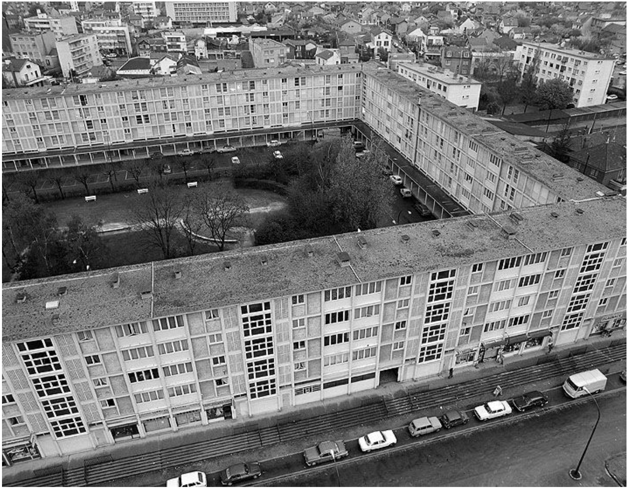
Bâtiment à l'ouest de la grande Muette. Campagne photographique, lors de la destruction du bâtiment en 1976.
