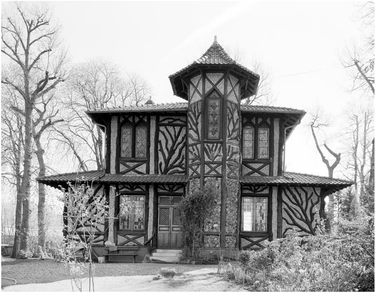
La façade principale, avec l'entrée.
