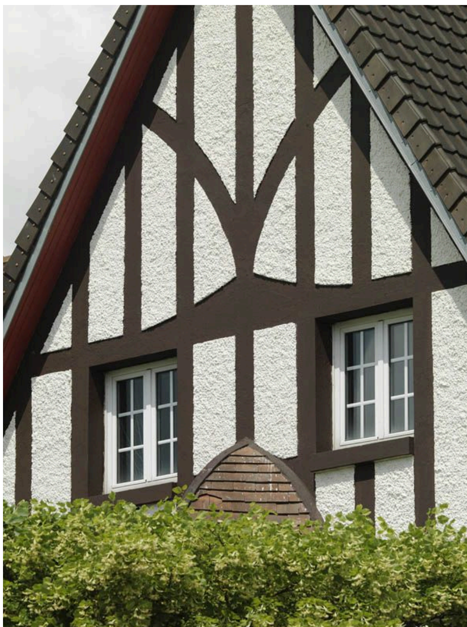
Détail de la façade. Les faux pans de bois.
