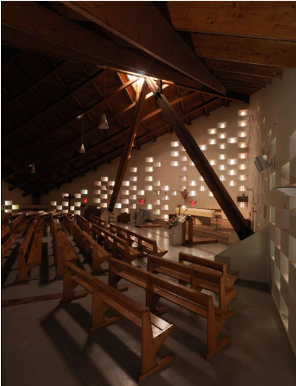
Vue intérieure. Les parois sont percées d'ouvertures ébrasées laissant perler l'éclairage naturel, dont l'intensité varie avec le jour. La charpente lamellée-collée est axée sur la diagonale.
