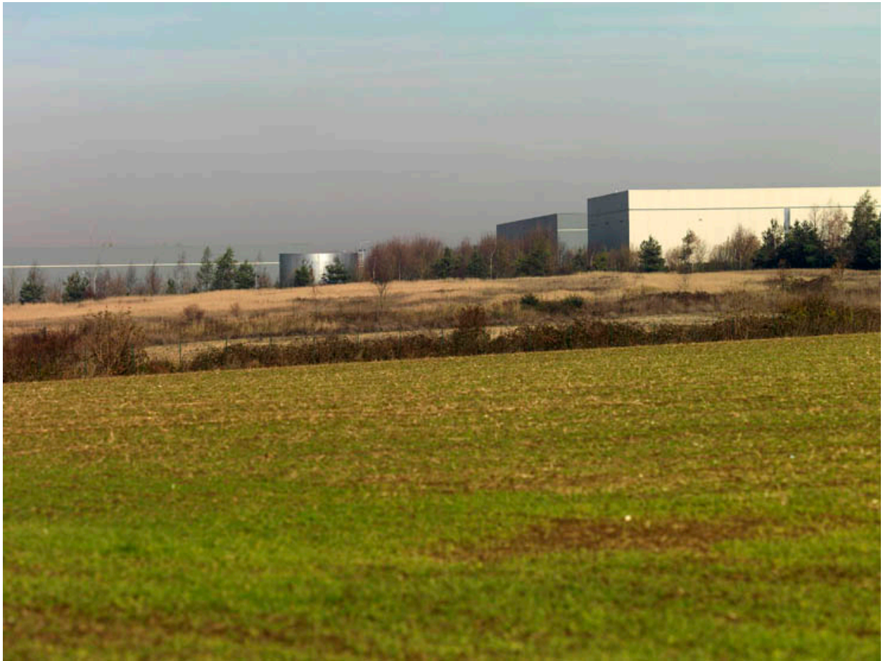
Saint-Witz, D16. Entrepôts logistiques de la ZAC Terres des Guepelles.
