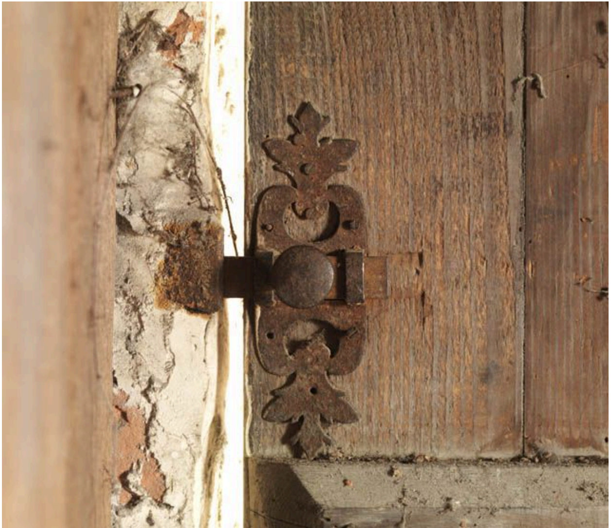
Ancien atelier du serrurier, étage de comble, détail de ferronnerie.
