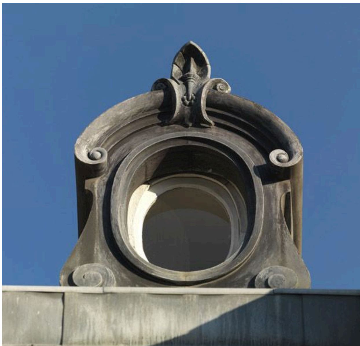
Lucarne ovale couronnant la travée centrale.
