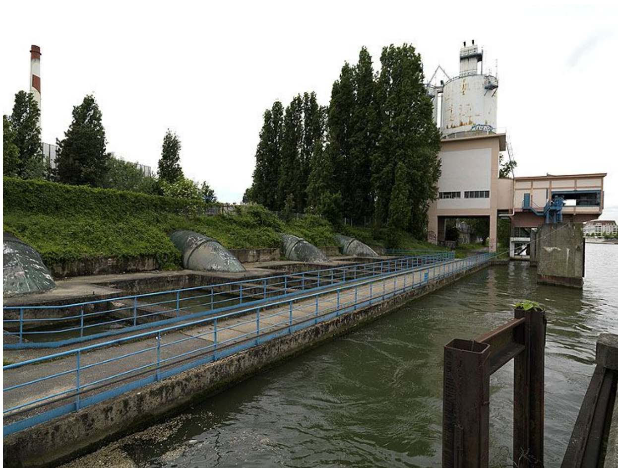
Vitry-sur-Seine. Prise d'eau et appontement, au niveau de la centrale thermique.
