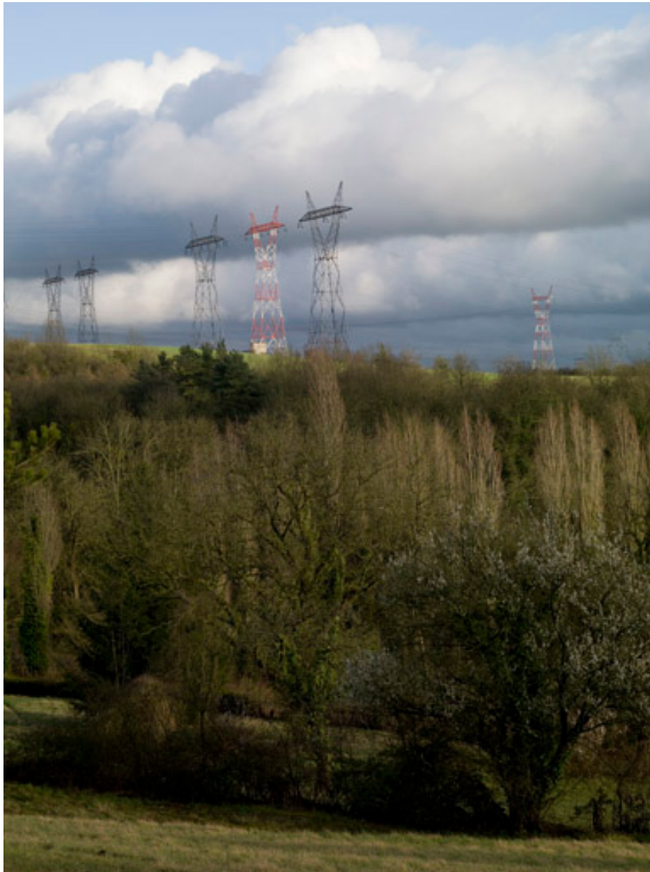
Pylones lignes haute tension.
