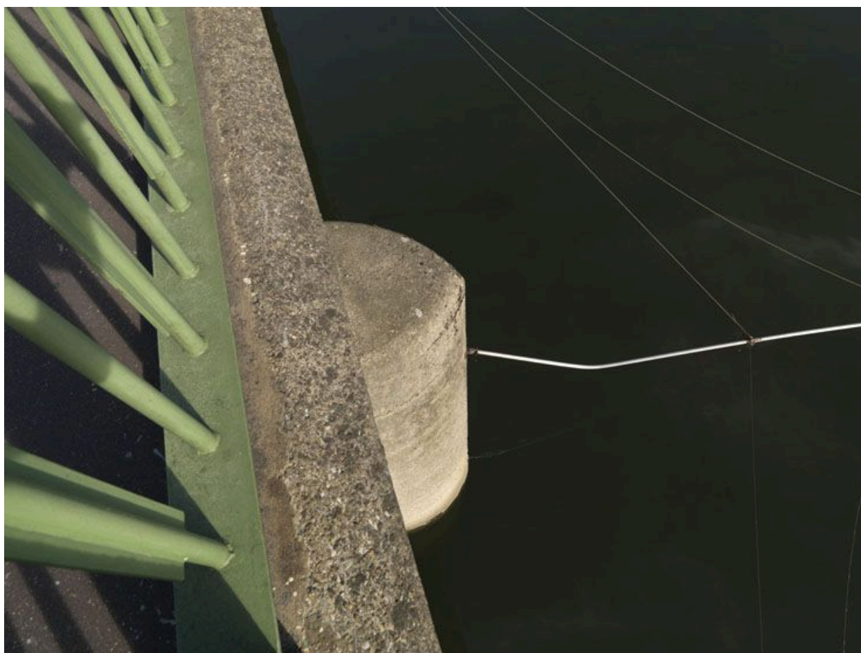
Partie supérieure d'une pile en éperon vue depuis le pont.
