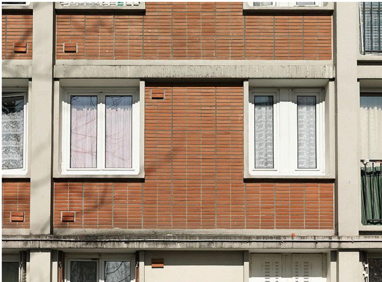
94, Ivry-sur-Seine, immeuble dit Cité Gagarine, allée Gagarine. Détail de la façade à structure de béton et remplissage de panneaux préfabriqués de briques.
