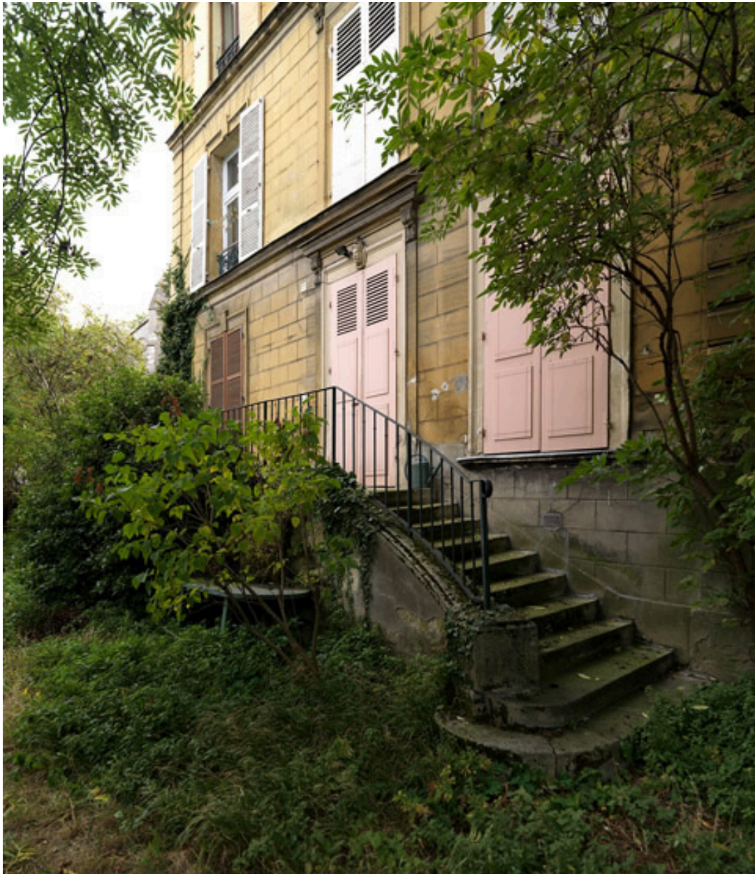
Villeneuve-Saint-Georges, maison de maître dite maison de Victor Duruy, 10 rue Victor-Duruy. Détail du perron.
