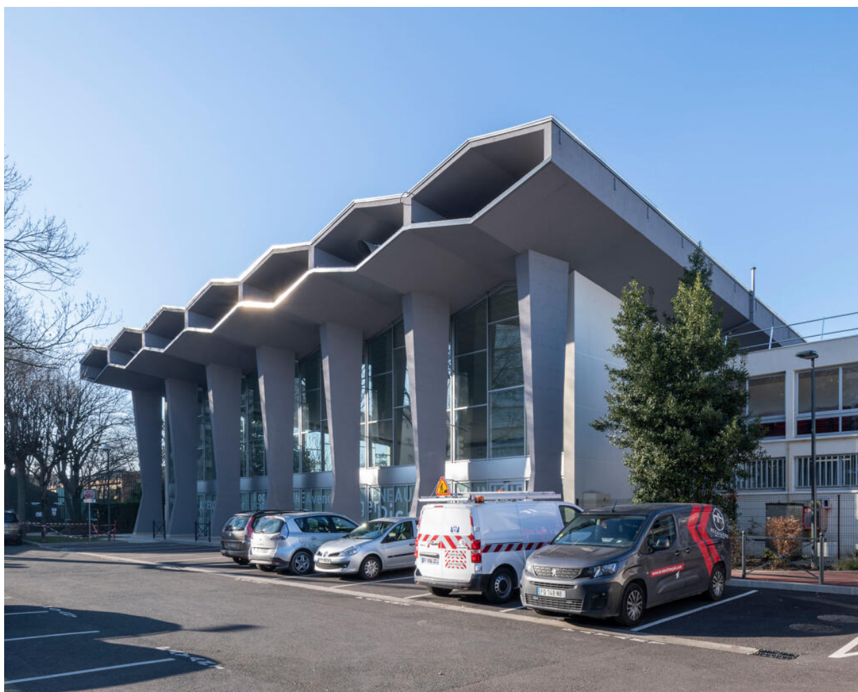
La piscine Roger Aveneau. Façade principale et entrée.
