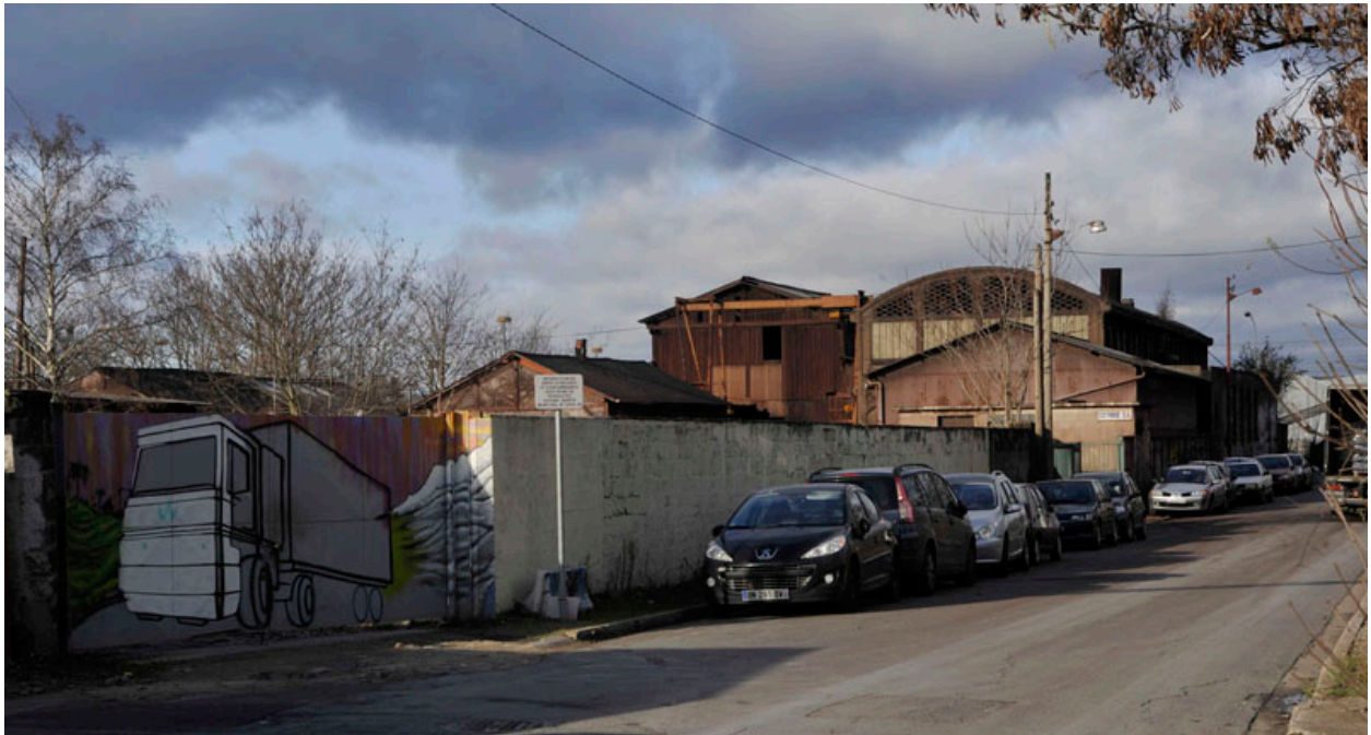
Poissy, usine métallurgique Oxymine S.A. (Oxydes Minéraux de Poissy), 2 rue Picquenard. Vue générale de l'usine. On distingue à droite un atelier couvert d'un toit bombé en voile mince de béton (années 1950).
