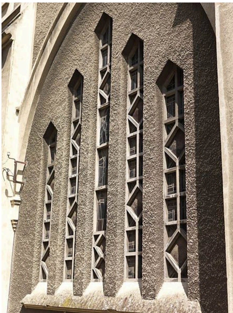
Baie côté sud de la nouvelle chapelle.
