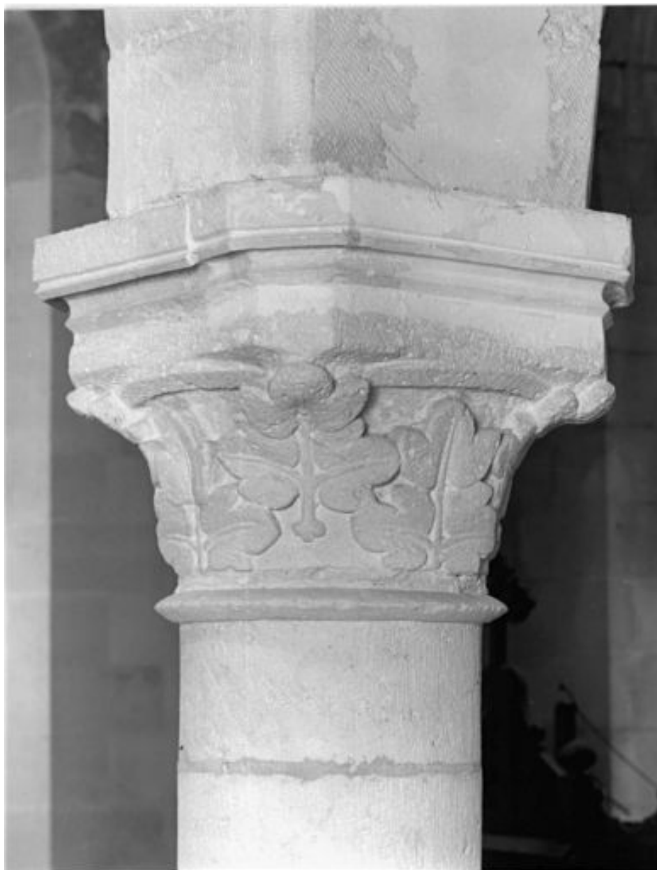
Chapiteau du premier support sud de la nef.
