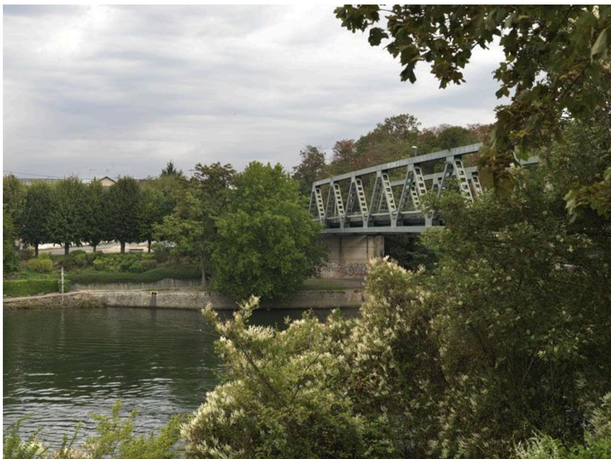
Poutres métalliques en treillis Warren vues depuis les berges de l'île de Rangipont. On aperçoit la culée en béton sur les berges.
