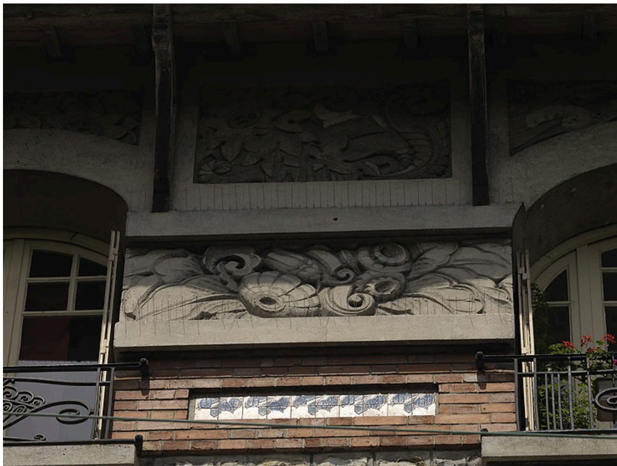
Détail des bas-reliefs de béton à motif végétal situés au dernier étage.
