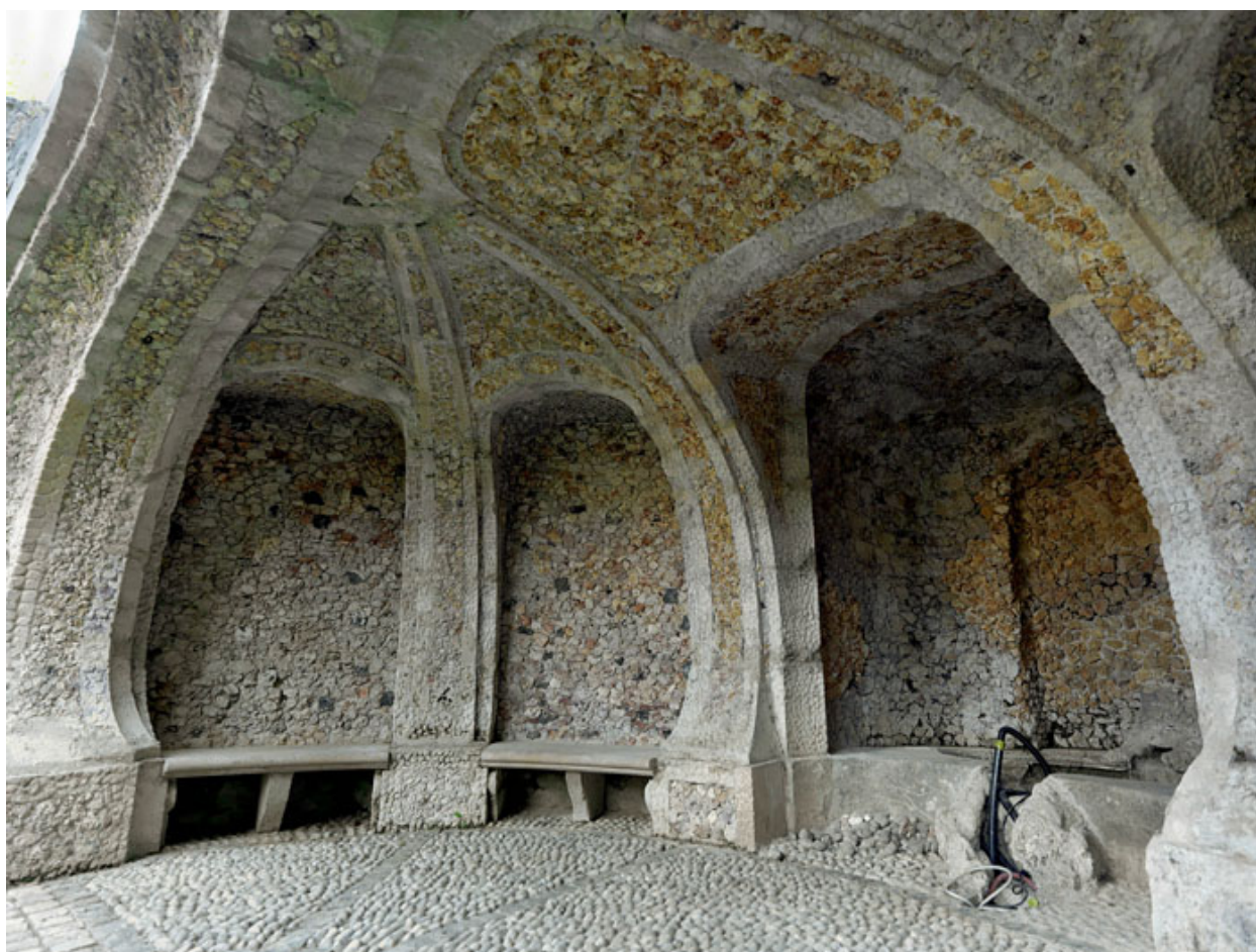
Nymphée de Villeflix, 10 allée de la Grotte, vers 1700. Vue intérieure.
