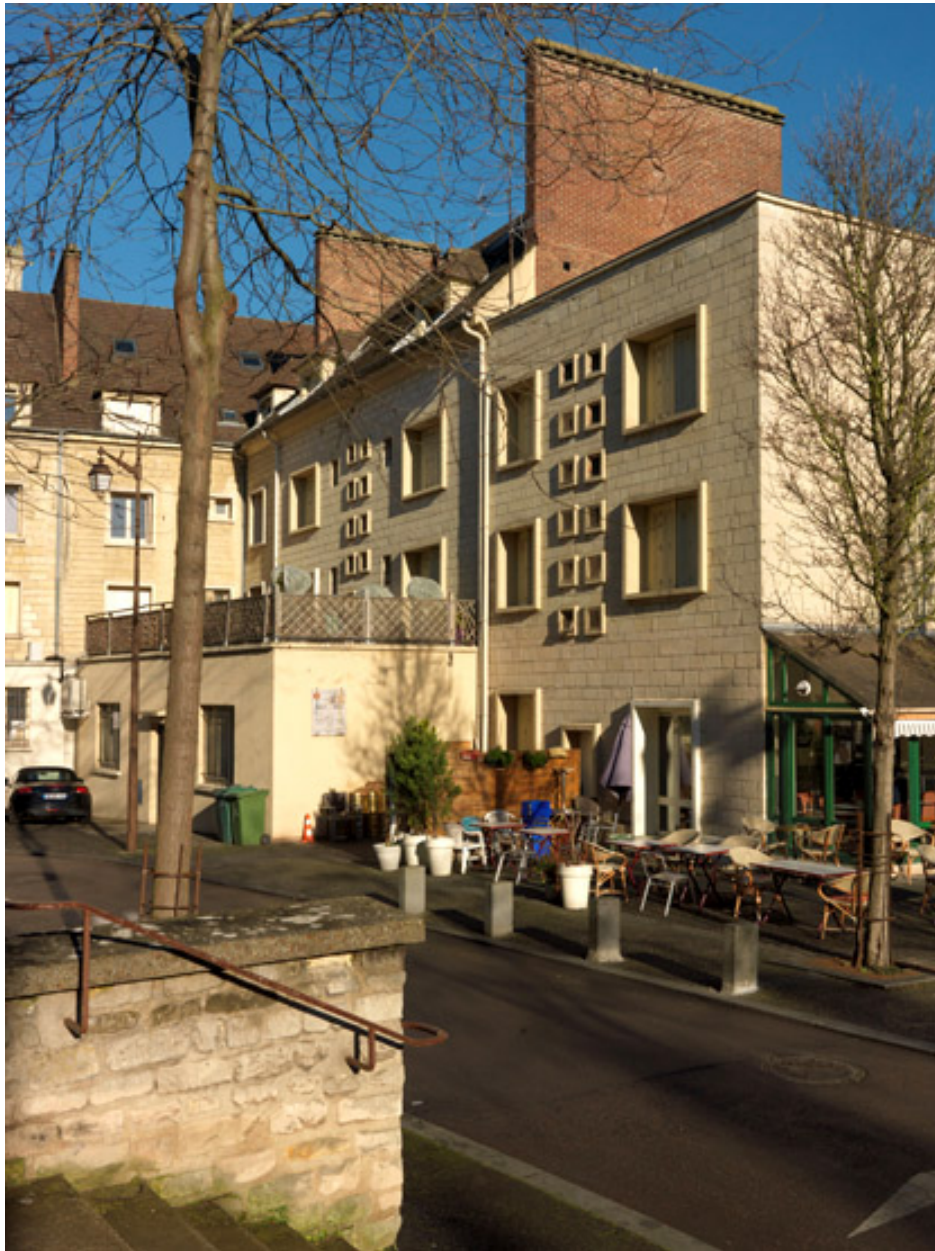
La façade arrière de l'immeuble de l'îlot F à l'angle de la Rue Nationale et de la rue Marie et Robert Dubois.
