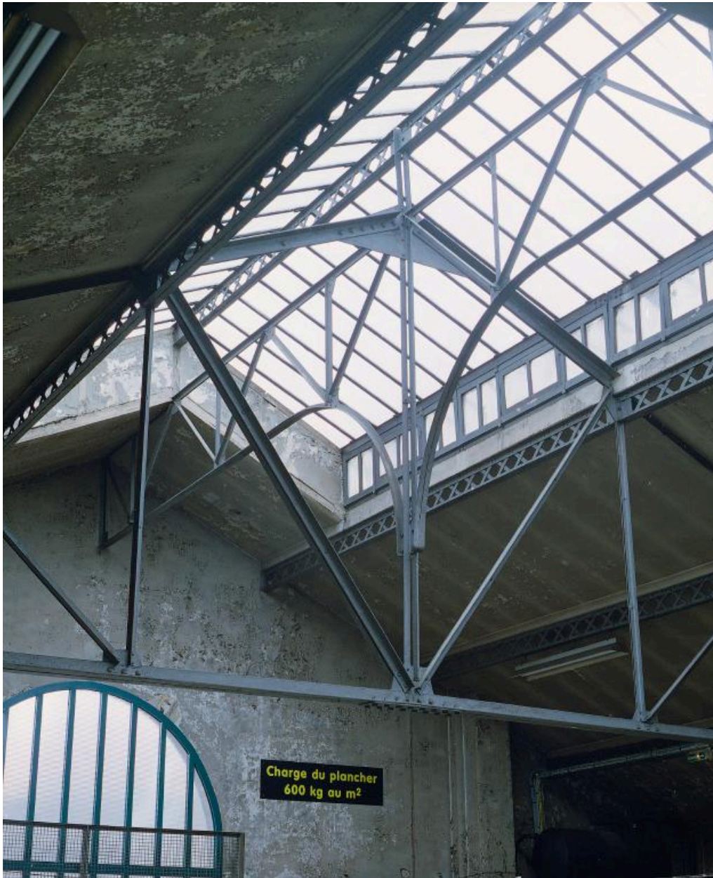
Détail de la charpente métallique de l'atelier de chaudronnerie de l'usine Rateau (1917).
