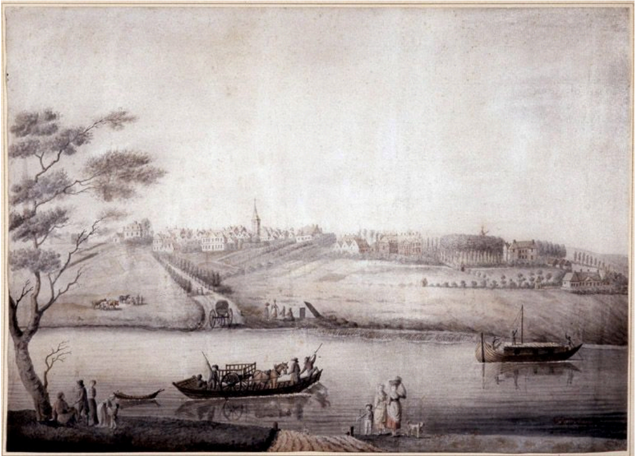
Dessin aquarellé du début du XIXe siècle représentant le bac qui a été remplacé en 1831 par le pont de Bry. Dessin, début XIXe siècle. (Musée Nogent-sur-Marne)
