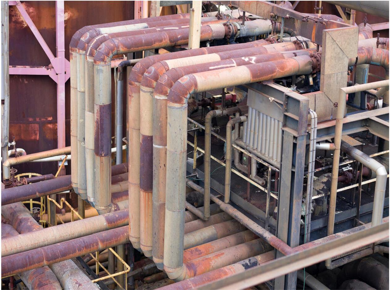
Unités Ouest - Zone de distillation (Unité 612). Vannes d'alimentation des différentes passes du four 612 F1, permettant de contrôler les flux d'entrée de pétrole brut dans le four (huit vannes automatiques, quatre passes par cellule).
