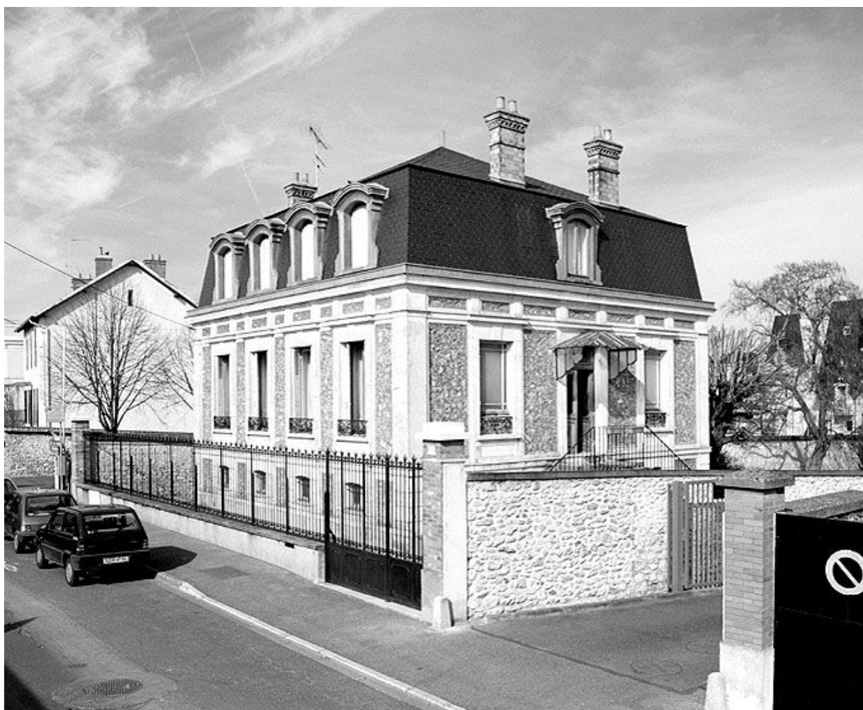
Maison de maître, 19 rue Eugène-Gonon, combinant moellons apparents et modénature de plâtre pour les murs, ardoise pour le toit.
